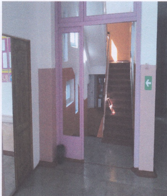
Фото №4 Пути движения внутри здания
