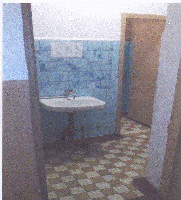
Фото № 10 Санитарно- гигиеническое помещение (туалет)
