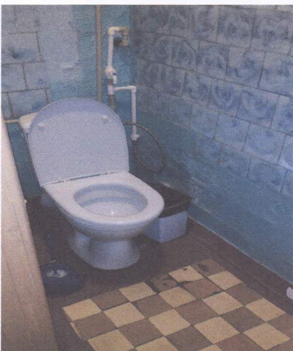
Фото № 11 Санитарно- гигиеническое помещение ( туалет)
