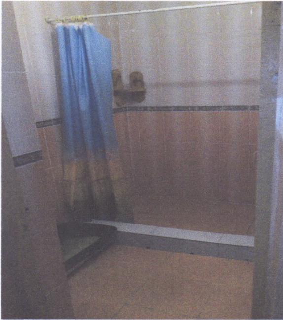
Фото № 9 Санитарно- гигиеническое помещение (душевая)
