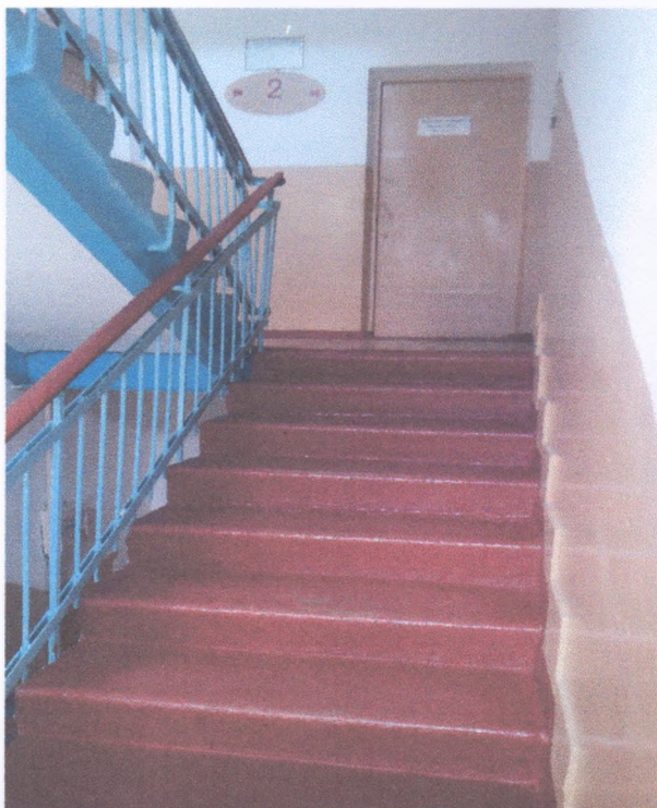
Фото № 13 Пути движения внутри здания
