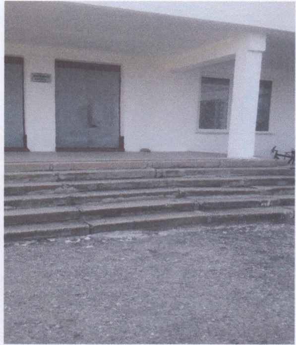
фото № 2 Вход в здание
