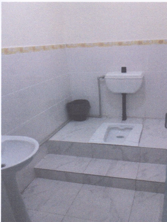
Фото № 7 Санитарно- гигиеническое помещение (туалет)
